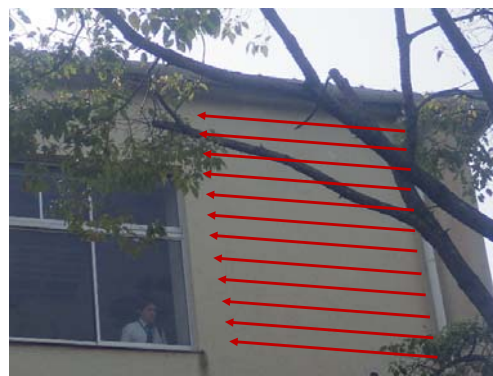
3 F 東面（屋外側）
