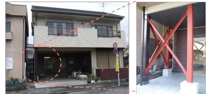
1階の耐震補強工事
