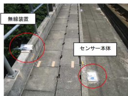
図-7 センサー設置状況
