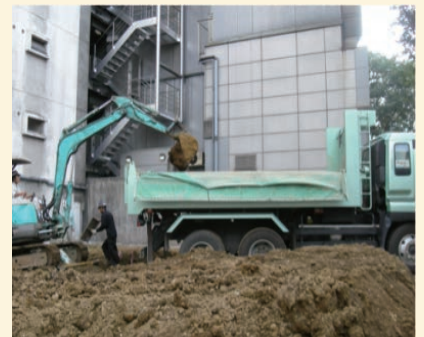
汚染土壌掘削工事
