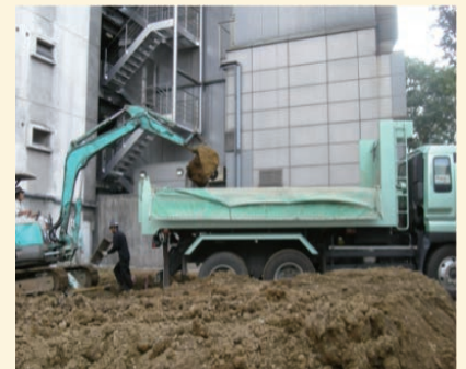
汚染土壌掘削工事
