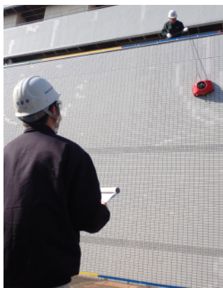
屋上にウォールサーベイロボをセッティングします。
