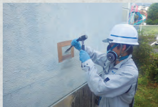
外壁塗膜採取状況
