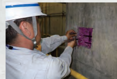
中性化深さ測定
