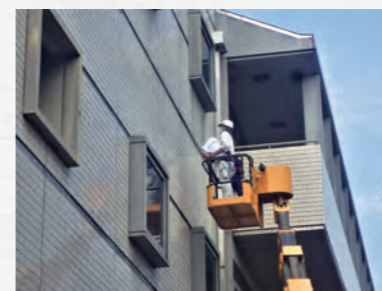
テストハンマーによる打診調査
