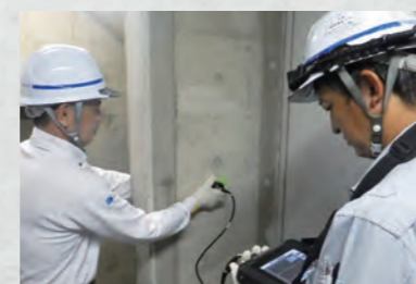
超音波による健全性調査
