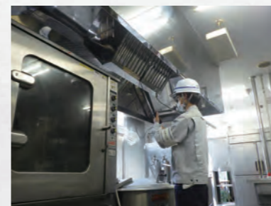
建築設備点検
