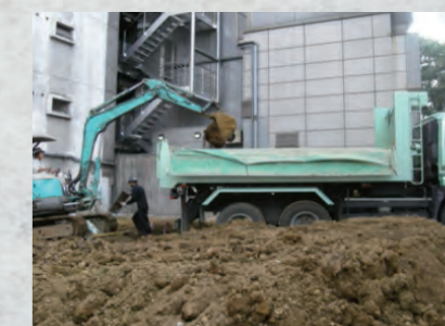
土壌汚染対策工事
