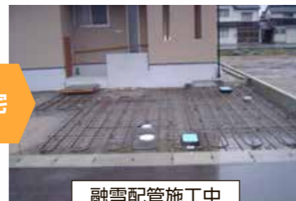
融雪配管施工中
