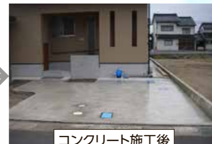
コンクリート施工後
