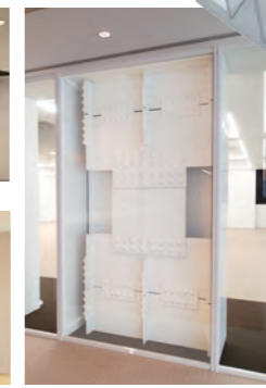
新築施工写真
