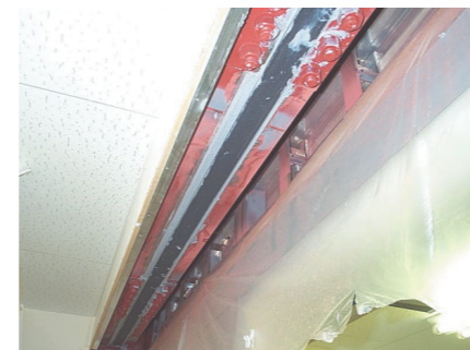
鉄骨梁の補強
