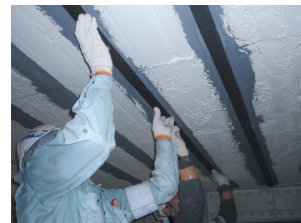
床スラブの補強
