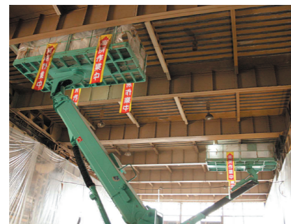
高所の床スラブ補強
