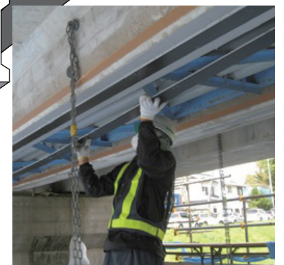
桁の曲げ補強
