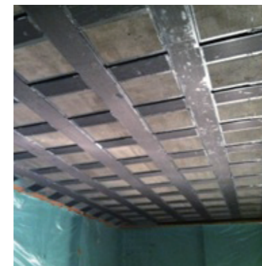
床版下面の補強
