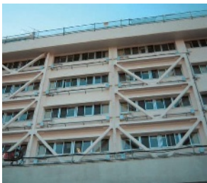
外付け鉄骨フレース
