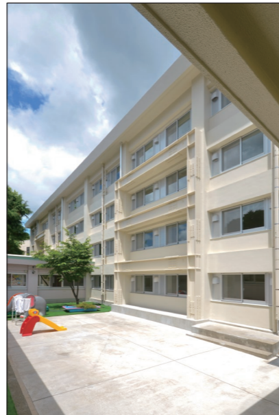
弘前大学学生支援センター 設計:(株)梓設計/施工:(株)奥村組
