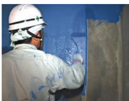
ローラーによる塗布
