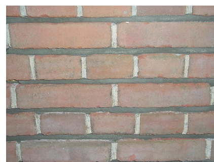
置換目地モルタルにて埋戻し
