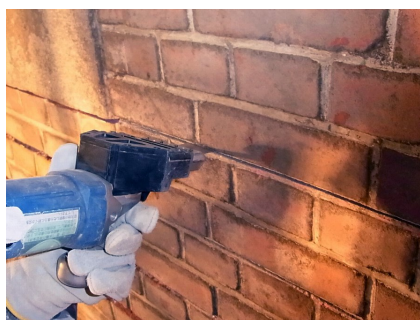
既存目地を切削
