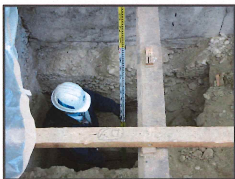
基礎掘削による出来型確認調査 基礎掘削による出来型確認調査
