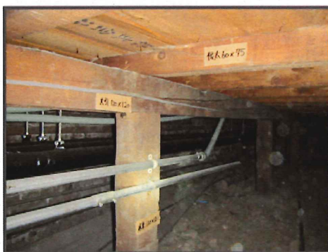
床下木軸組実測調査
