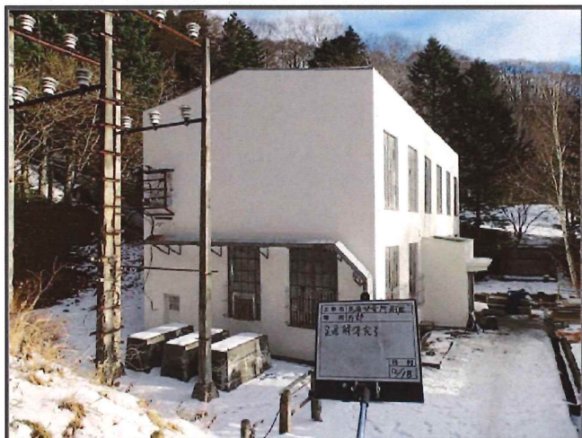
■王子製紙恵庭発電所(恵庭市) 鉄骨造 建築年:昭和3年
