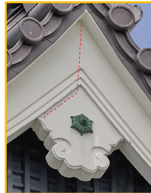
赤破線：画像で認識できるひび割れの右 or 下に記載したもの
