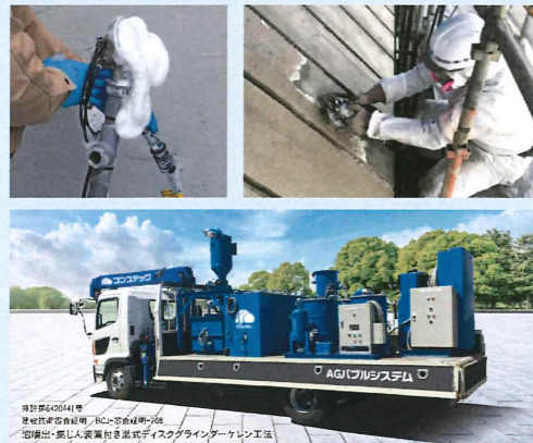
泡で粉じんを絡め取り吸引する工法
