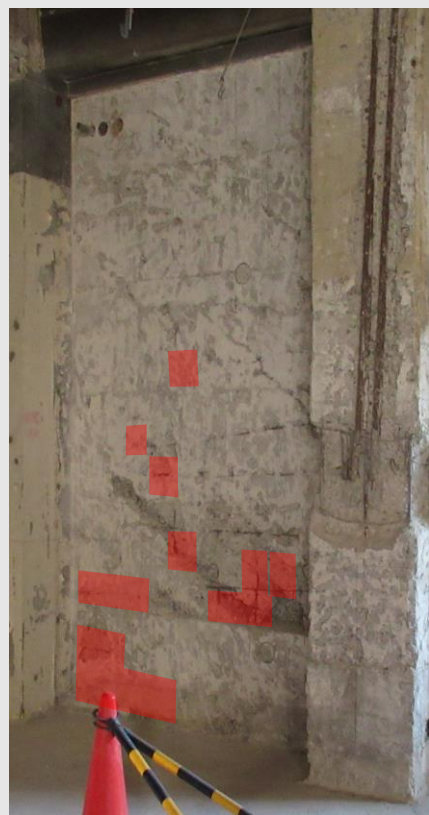
仕上げ後の状況確認
