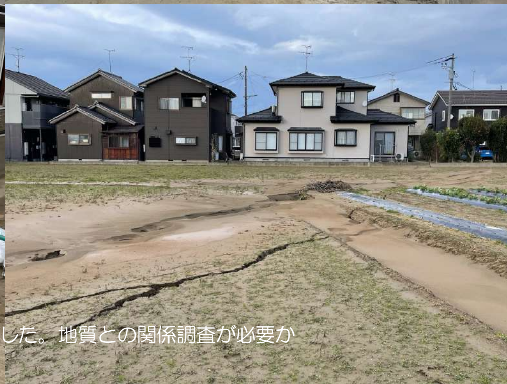
激しい液状化で建物は沈下した。全体が地盤沈下したと推測されるが、道路側が隆起して建物は傾斜したか
