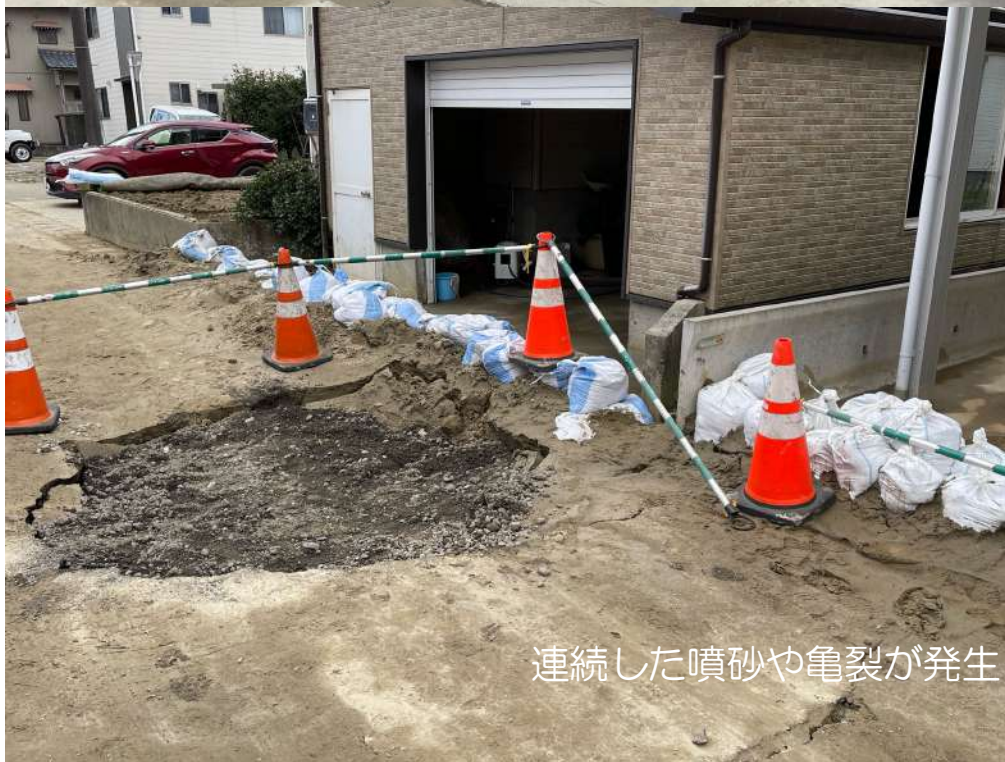
激しい液状化で建物は沈下した。全体が地盤沈下したと推測されるが、道路側が隆起して建物は傾斜したか
