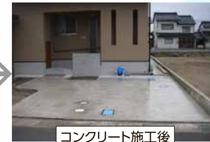
コンクリート施工後
