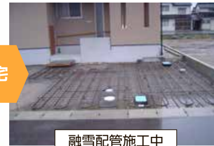
融雪配管施工中
