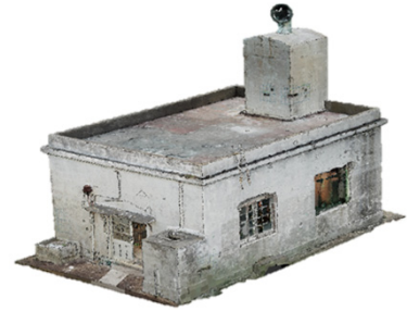
野島埼灯台霧信号舎
