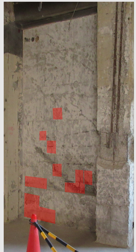
仕上げ取外し後の状況確認
