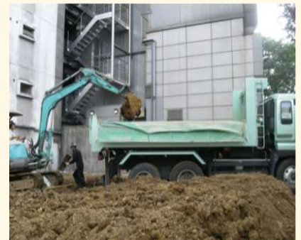
汚染土壌掘削工事
