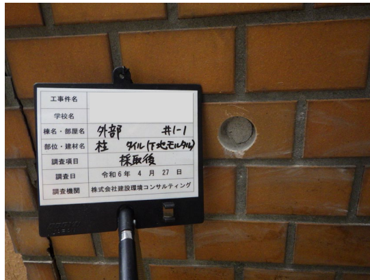
タイル下地モルタル
