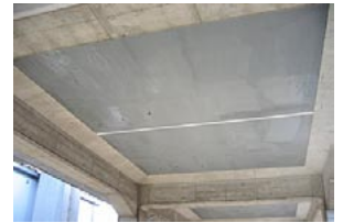
高架橋床版への適用
