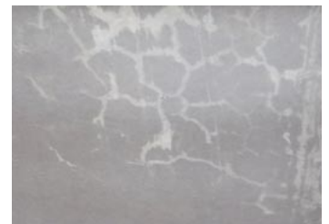
ひび割れ箇所に吹付け
