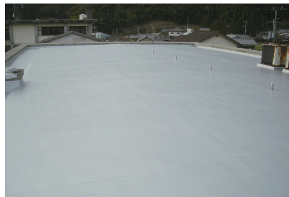
リアルーフ工法(脱気工法)
