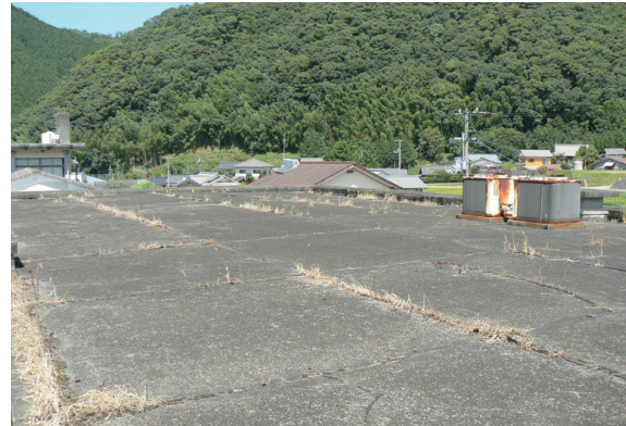
アスファルト防水(保護工法)
