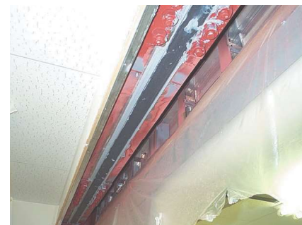
鉄骨梁の補強
