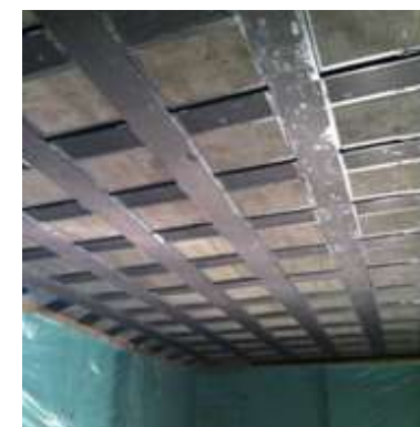
床版下面の補強
