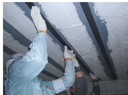
床スラブの補強
