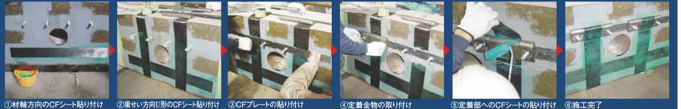
①材軸方向のCFシート貼り付け ②梁せい方向U形のCFシート貼り付け ③CFプレートの貼り付け ④定着金物の取り付け ⑤定着部へのCFシートの貼り付け ⑥施工完了
