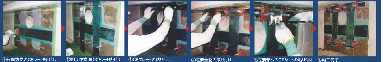
①材軸方向のCFシート貼り付け ②梁せい方向のCFシート貼り付け ③CFプレートの貼り付け ④定着金物の取り付け ⑤定着部へのCFシートの貼り付け ⑥施工完了
