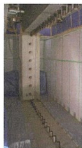
1.鋼管コッター施工完了
