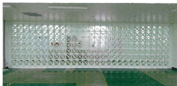
3.UFCブロック組積完了
