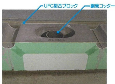
UFC接合ブロック及び鋼管コッター
