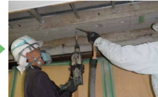
② アンカー打設
