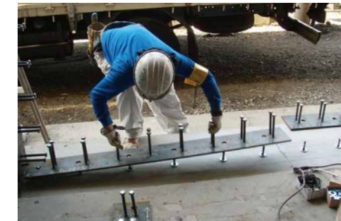
③ 接合鋼板取付
