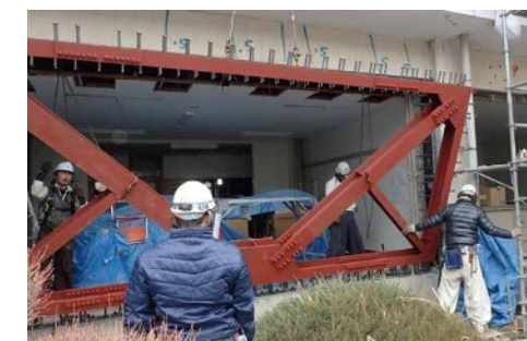
⑤ 鉄骨ブレース取付 ⑥ 割裂防止筋 配筋
