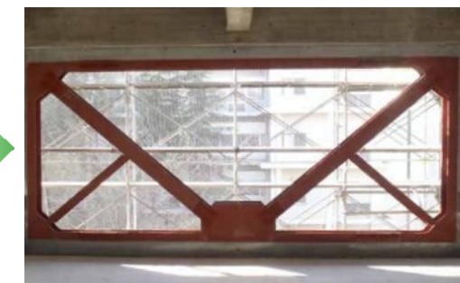
⑦ 無収縮モルタル注入
