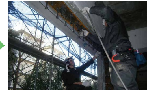
④ エポキシ樹脂注入
