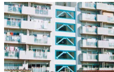
兵庫県 A高層団地
