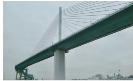
荒津大橋 (福岡県)
