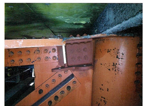
トラス梁への適用事例（屋根）
