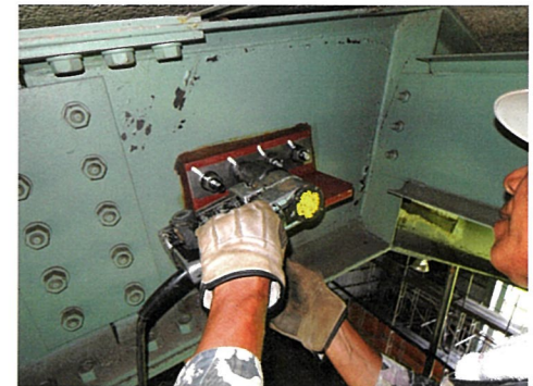
定着金具の取付（屋根）
