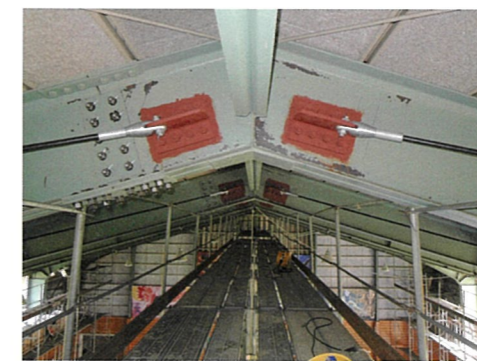
梁頂部の定着金具（屋根）
