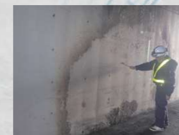
鉄筋コンクリート造の火害調査
