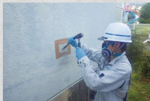
外壁塗膜採取状況
