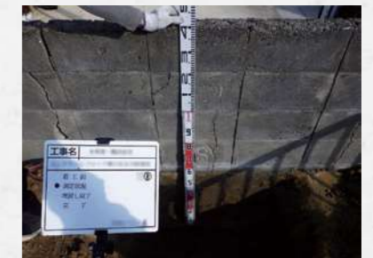
ブロック塀調査
