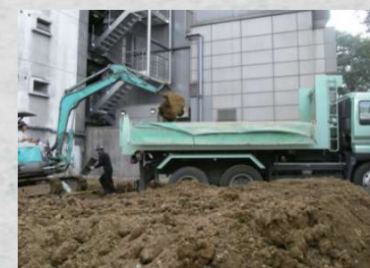
土壌汚染対策工事
