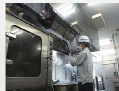
建築設備点検
