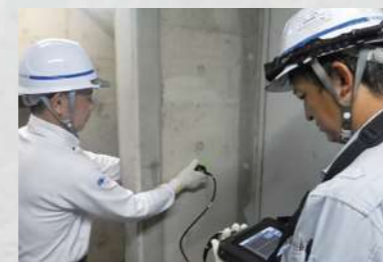
超音波による健全性調査
