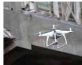
建物外観の調査状況
