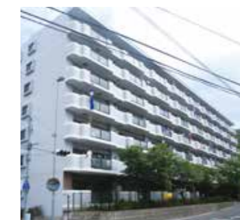
施工後(リアネットE工法)
