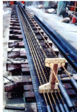
プレテン桁の製作
