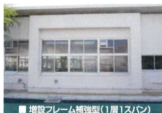
■ 増設フレーム補強型(1層1スパン)
