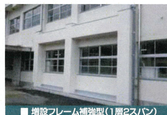
■ 増設フレーム補強型(1層2スパン)
