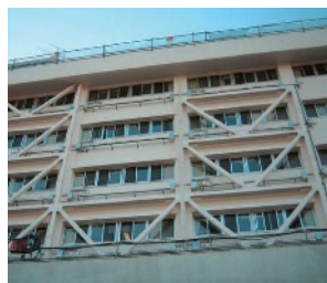
外付け鉄骨ブレース
