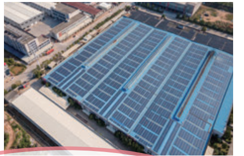
太陽光パネルの設置
