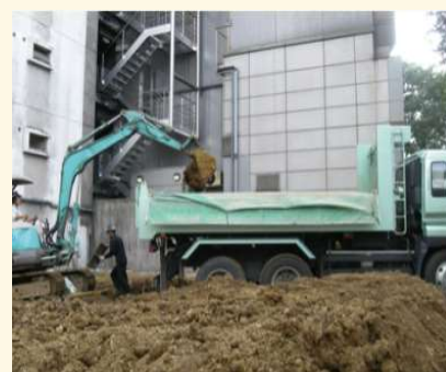
汚染土壌掘削工事
