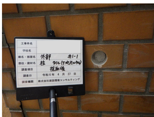
タイル下地モルタル
