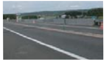
道路の壁高欄など
