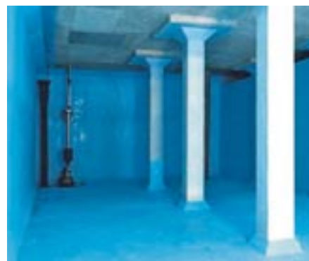
施工事例：池中野配水池（伊東市）
