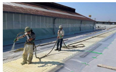
スプレー施工によりシームレスな防水層
