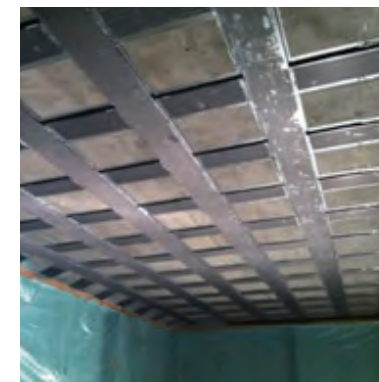
床版下面の補強
