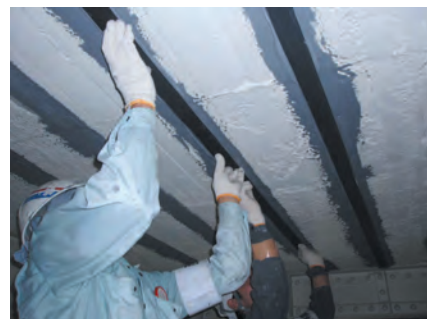
床スラブの補強
