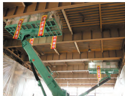
高所の床スラブ補強
