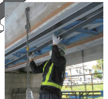
桁の曲げ補強
