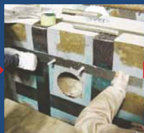
③CFプレートの貼り付け
