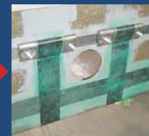
⑥施工完了
