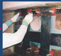
④定着金物の取り付け
