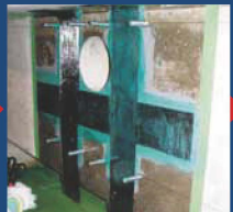
②梁せい方向I形のCFシート貼り付け
