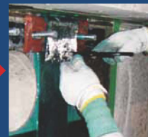
⑤定着部へのCFシートの貼り付け
