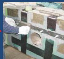
④定着金物の取り付け
