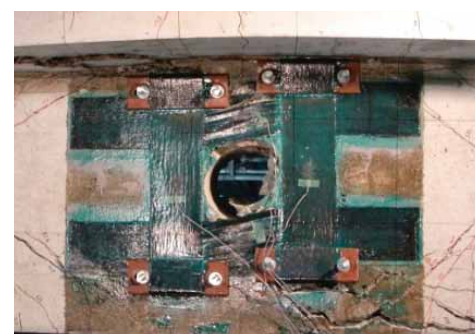
実大有孔梁を用いた構造実験
