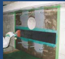
①材軸方向のCFシート貼り付け
