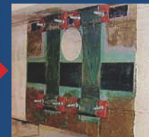
⑥施工完了
