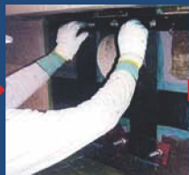
③CFプレートの貼り付け
