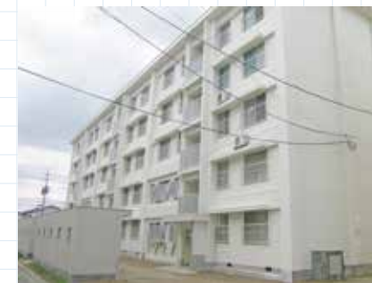
集合住宅の外壁改修
