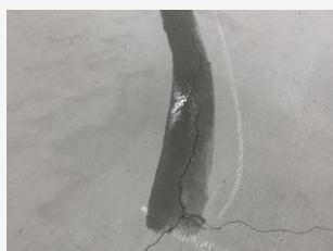
①補修箇所の水湿し
