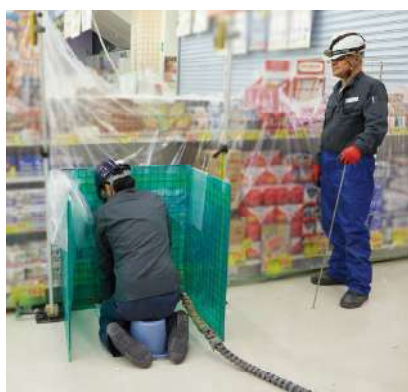
店舗での施工の様子
