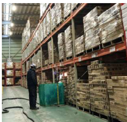
物流倉庫での施工の様子
