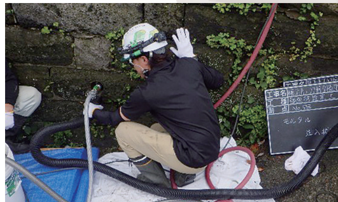
グラウト注入
