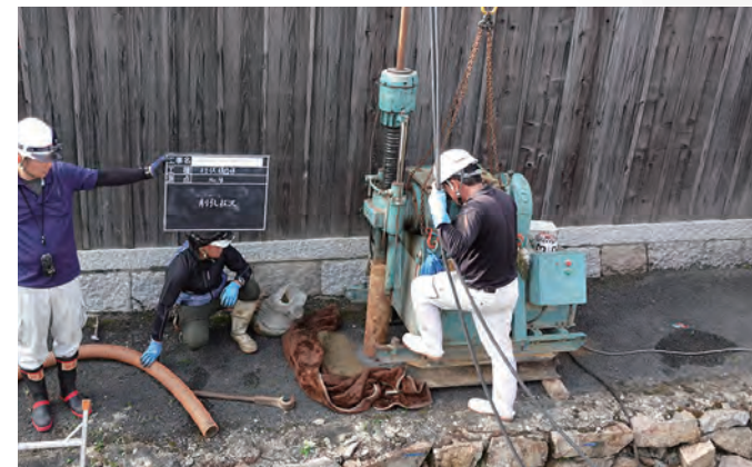
柱状構造体施工
