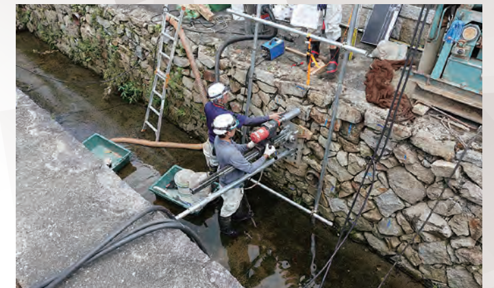
バットレスアンカー施工
