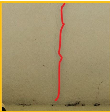
赤線：画像で認識できるひび割れの右に記載したもの
