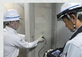
超音波による健全性調査
