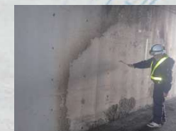
鉄筋コンクリート造の火害調査
