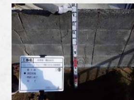
ブロック塀調査
