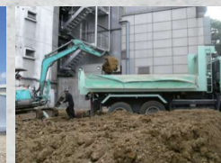
土壌汚染対策工事
