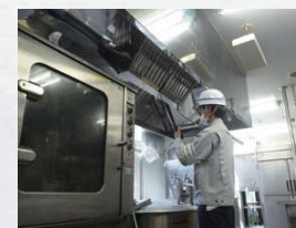
建築設備点検
